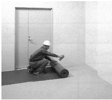
写真:接着剤散布時
