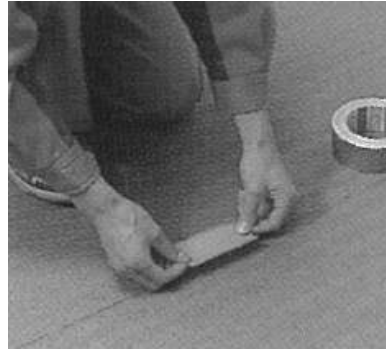
写真:テープ貼付け時
