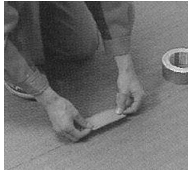
写真:テープ貼付け時
