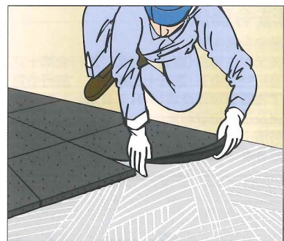
●ゴムチップ床材の施工に
