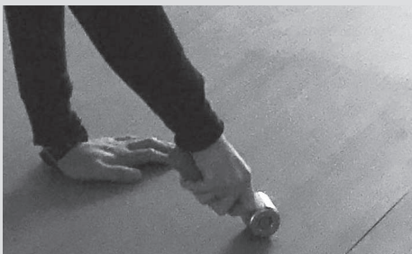
ハンドローラー等を用いて、メラミンタイル床全体、端部や、目地部などを圧着してください。
