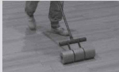
Tローラーや3本ローラーでメラミンタイルを十分に再圧着してください。
