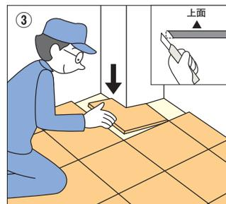
出隅の形にできあがったコルクタイルの壁に当たる面を斜めにカットし、出隅に敷き込みます。仕上げにハンドローラーで押さえます。
