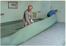
移動荷重用フロアの施工
